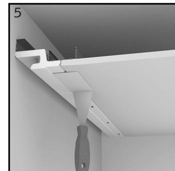
apply 1<sup>st</sup> layer of joint filler
